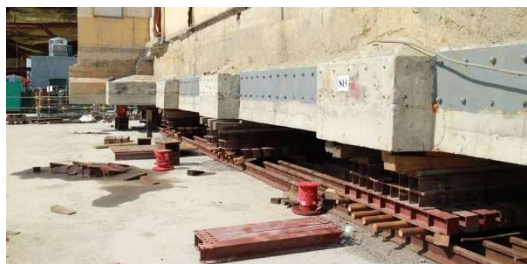
圖 10 高雄驛修建為願景館底下的油壓機工程
