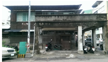
(圖 8)新濱街區磚木構造的混用倉庫建築
